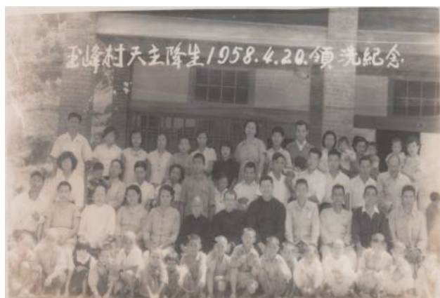
水里堂區管轄之玉峰村舊聖堂 (現今已不存在了)
